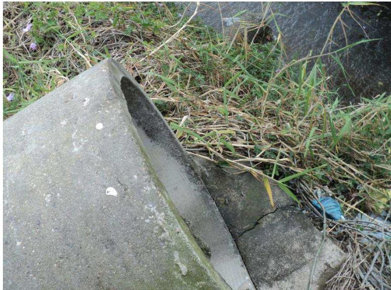
Figura 7: Galeria Existente Diâmetro: 600 mm.
