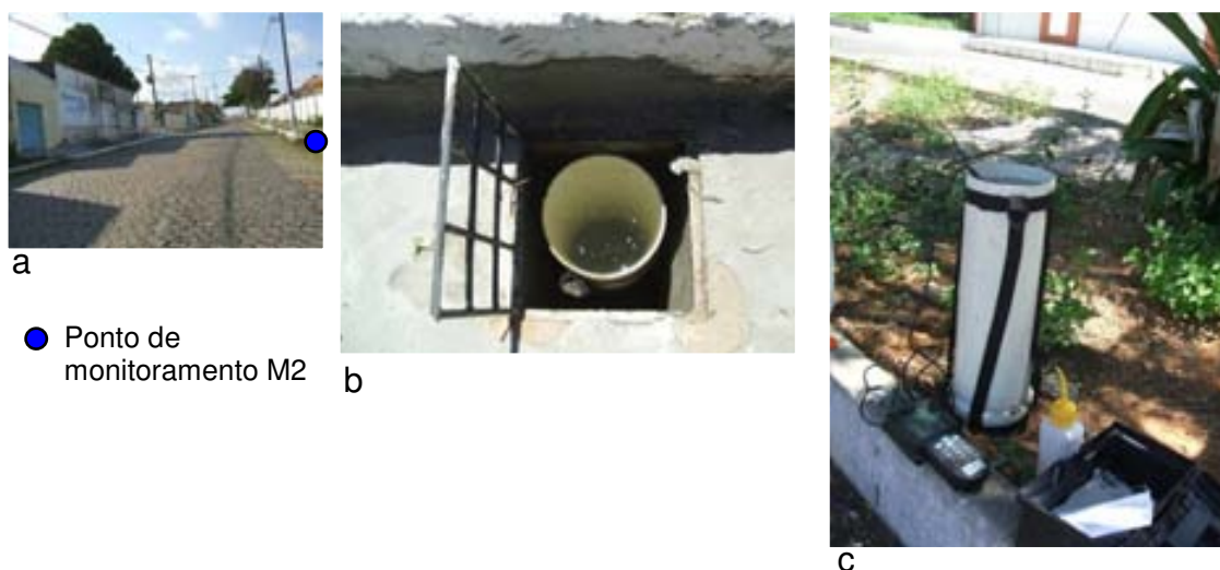
Figura 13 – a) Localização de um ponto de coleta simples (M2); b) Amostrador Simples instalado na sarjeta; c) Detalhe do procedimento para coleta de dados da amostra
